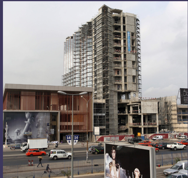
Un hôtel de luxe en construction à Abidjan, en Côte d'Ivoire. Le secteur de la construction est vulnérable au blanchiment d'argent et à l'implication de la 'Ndrangheta. © Joe Penney/Reuters
